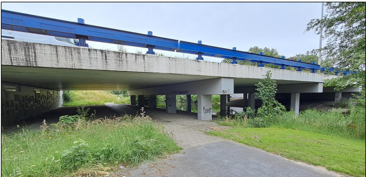
Figuur 6-11. Het viaduct van de Kamperfoelieweg, begeleidende structuren voor zoogdieren om het viaduct onderlangs te passeren ontbreken hier (knelpunt 11).
