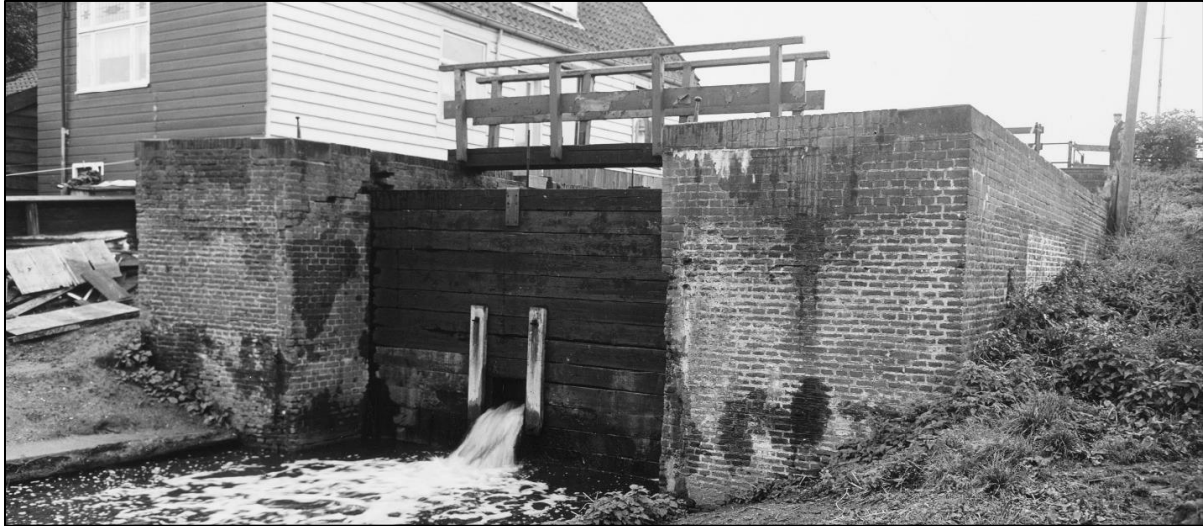
Figuur 6-6. De sluis aan de linker zijgevel van Oostzanerdijk 38, gezien vanaf de walkant van het Twiske. Foto afkomstig uit oktober 1964. Bron: Stadsarchief Gemeente Amsterdam.
