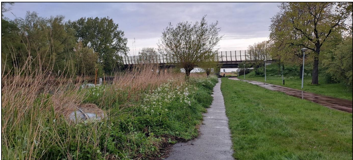
Figuur 4-6. Noordzijde deelgebied Twiske en Marssloot. Aan de linkerkant zijn de met bos begroeide eilandjes waar te nemen. De onderdoorgang onder de ring is ruim opgezet en vormt geen barrière voor fauna, ook voor recreanten is dit een aangename route om de drukte van de stad achter je te laten.
