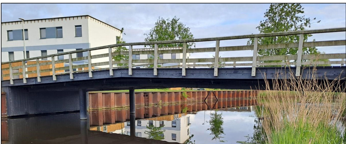
Figuur 6-4. Gedeelte van het Twiske met hoge stalen damwanden langs de westzijde.
