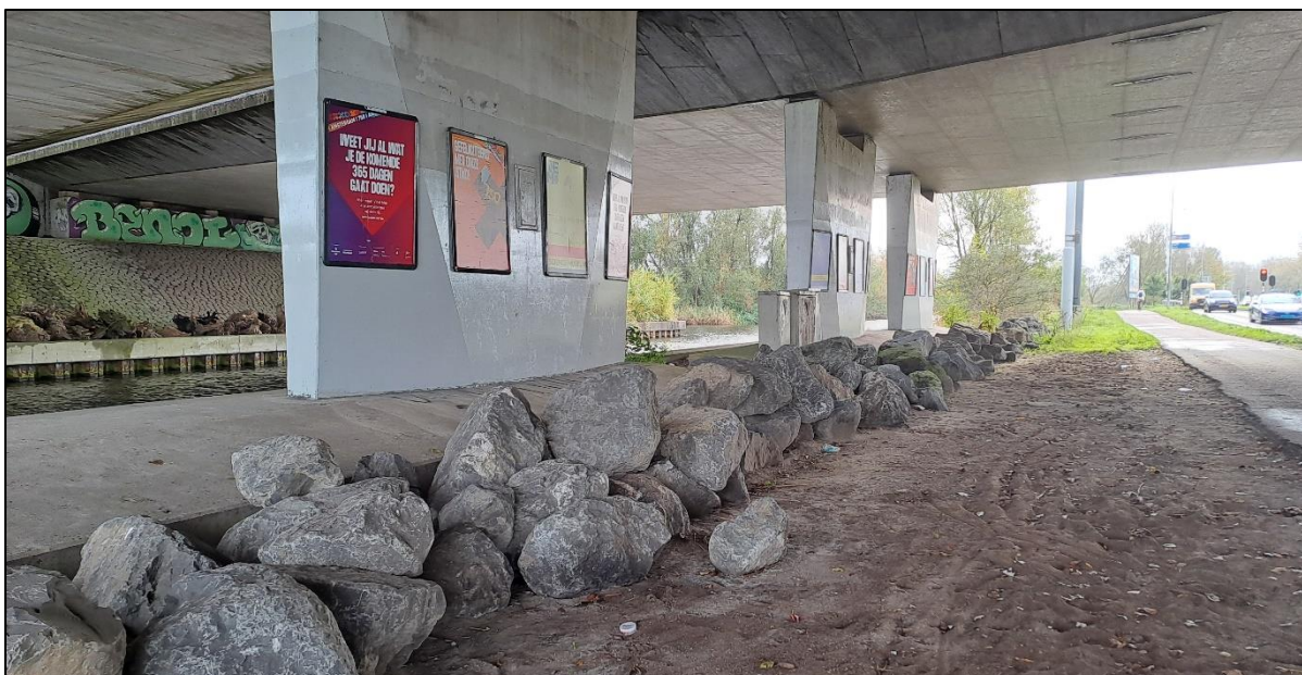
Figuur 6-7. De zwerfkeien onder het viaduct aan de IJdoornlaan moeten dienen als ecopassage voor grondgebonden soorten. Bij voorkeur is er ook nog een doorlopende groene vegetatie aanwezig onder het viaduct, water is veelal de beperkende factor voor de groei van grassen of kruiden.
